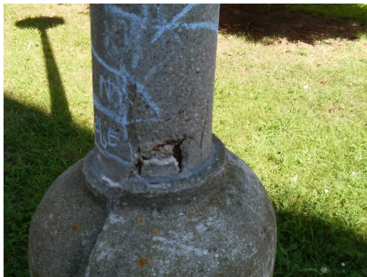
Obr. 10: Rozpadající se bet. stožár – nad patkou
